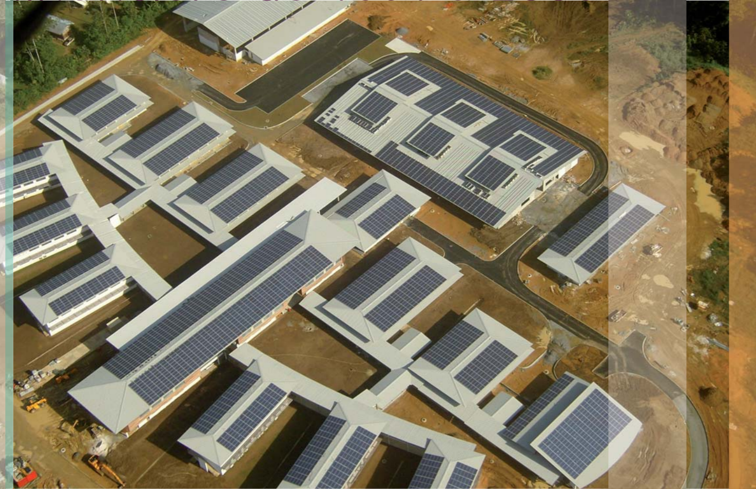
Une vue aérienne du lycée professionnel Saint-Laurent III.
